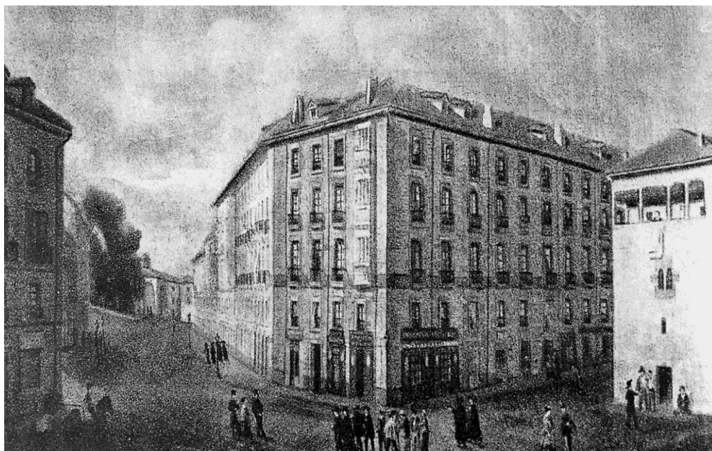
Figura 8.- Vista del Mentirón (1868), obra de Juan Ángel Sáez (1811-1873). Fotografía original conservada en el Archivo Municipal de Vitoria (AMV).
